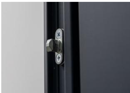
Zasuwnica bolcowa w drzwiach tarasowych HST
